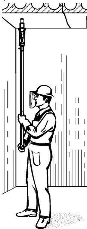
3.14 сурет. УК-2М бағанының көмегімен ғимарат жабынындағы тақтадағы саңылауды тесу
