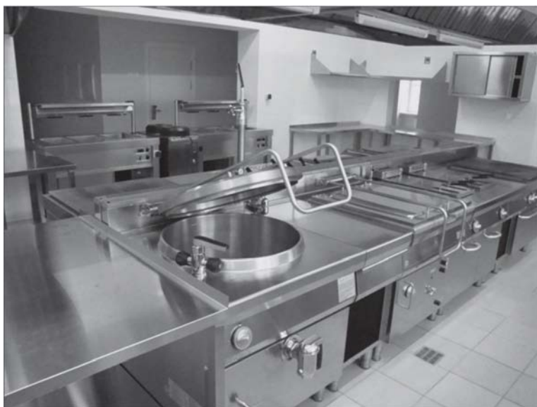
8.3.-сурет. Ыстық цехтың жылулық тізбесі (ас пісіретін қазан, тікелей қуыратын таба)
